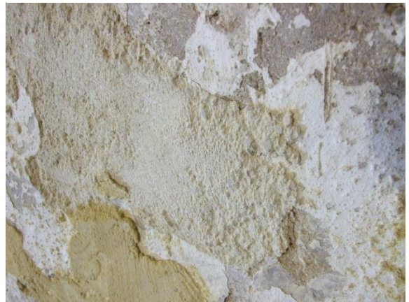
Bouchage au ciment débordant
