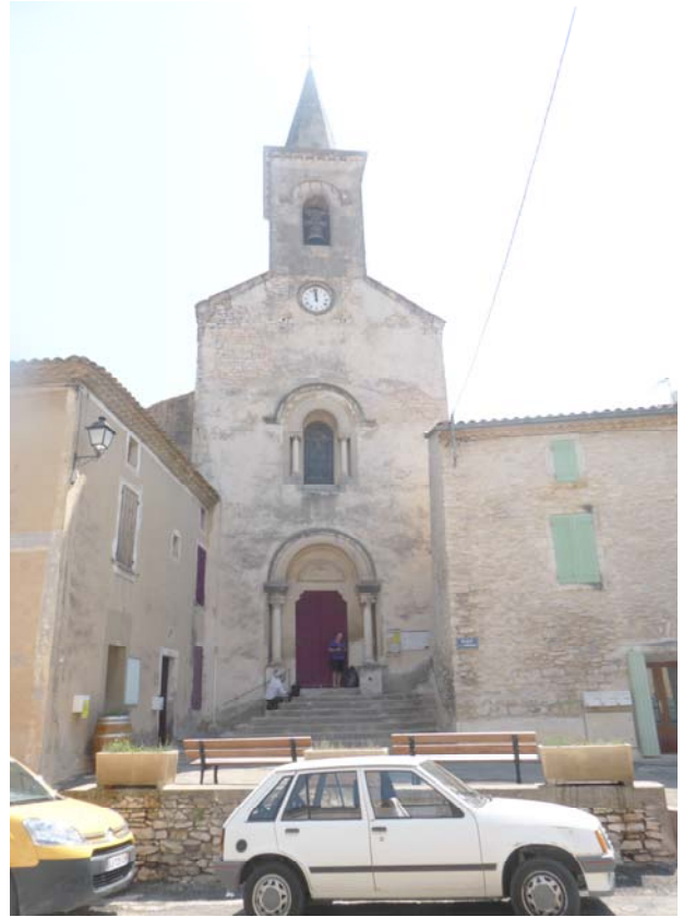
Pignon Ouest : la façade a été refaite par F. Degan lors de ses travaux à partir de 1887.
