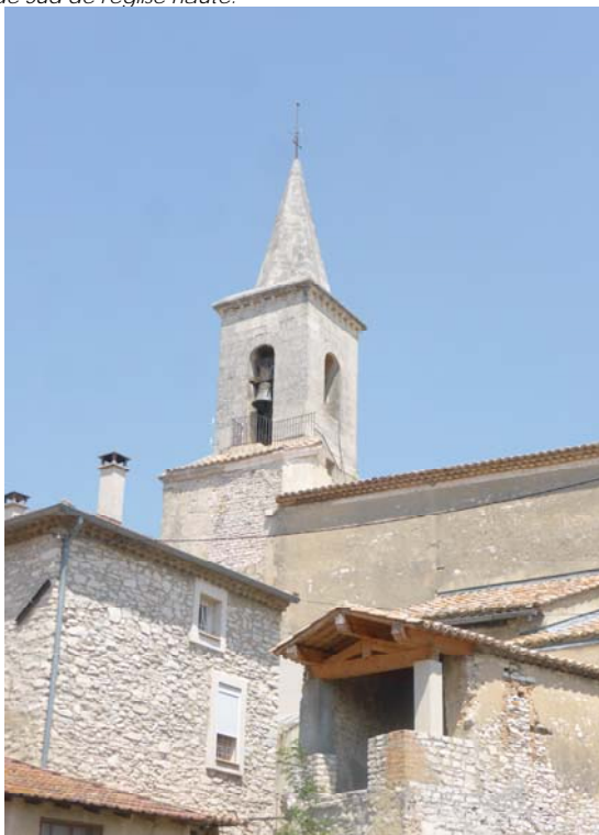
Des maisons sont accolées à la façade Sud de l'église. La flèche du clocher a été refaite par l'architecte F. Degan, à partir de 1887.
