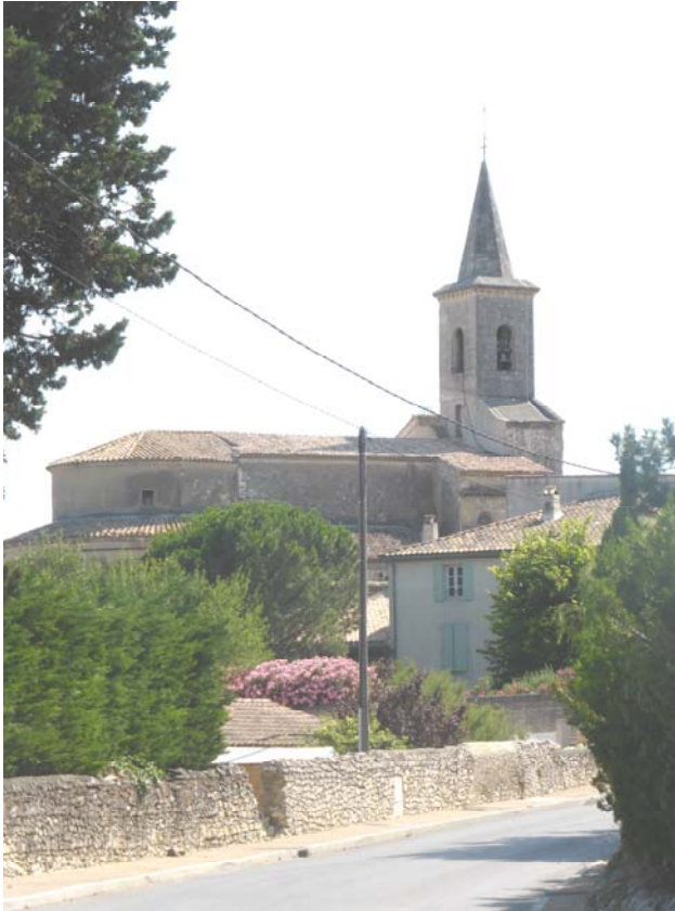
Vue lointaine de la façade Sud : on remarque la différence de couverture entre la première nef et l'agrandissement du chœur.
