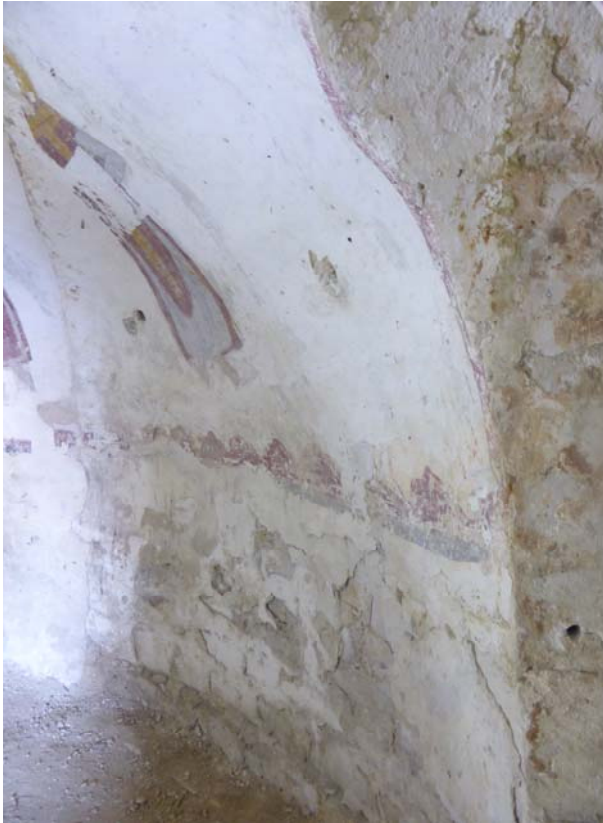
Trace de la baie préexistante : le bandeau rouge entourant la baie se retourne autour de l'ouverture.
