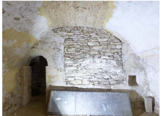
Mur Ouest : une porte conduit à un passage qui devait correspondre à l'escalier menant à l'église haute (en montant à droite vers le Nord) et qui se prolonge à gauche vers un puits situé au sud. Trace d'une ouverture rebouchée en moellons. Petite niche.
