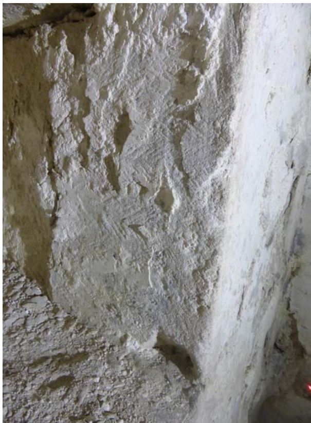
Pierre taillée du piédroit de la porte : le traitement du parement en arrêtes de poisson..
