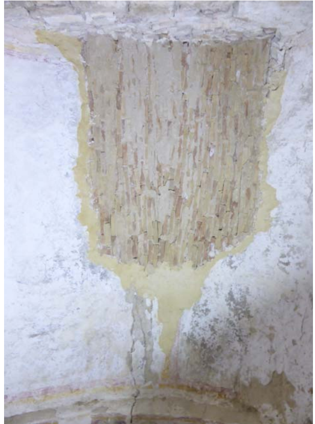
Sur la nef, ouverture du berceau puis comblement en brique.
