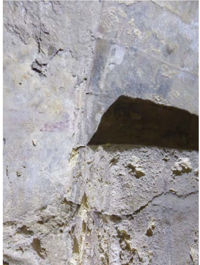
A la jonction entre la voûte et les premiers claveaux de l'arc, les vestiges d'enduits et de peintures (frise).
