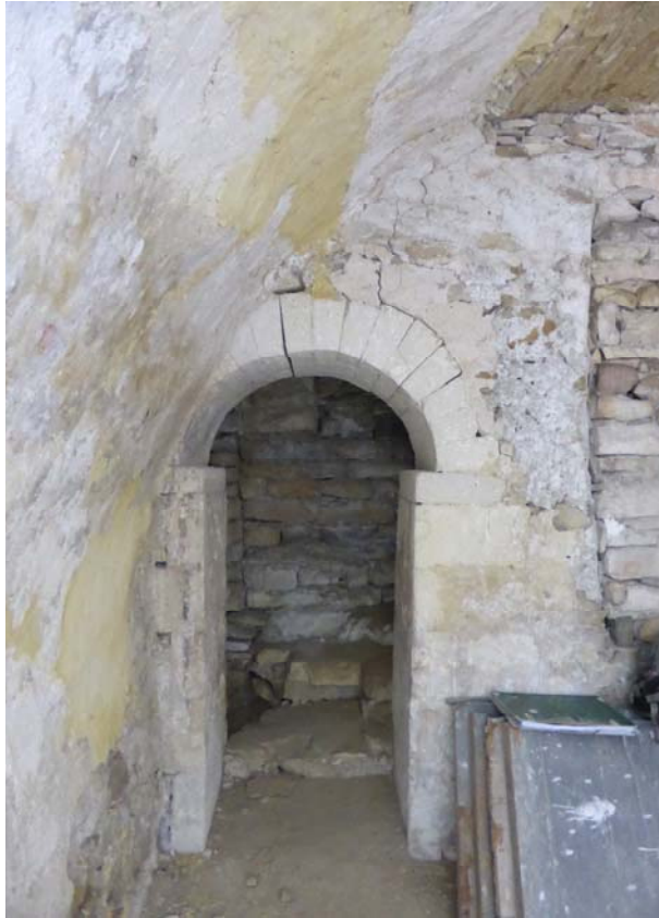
Porte couverte par un arc plein cintre en retrait des piédroits et jambages en pierre de taille.
