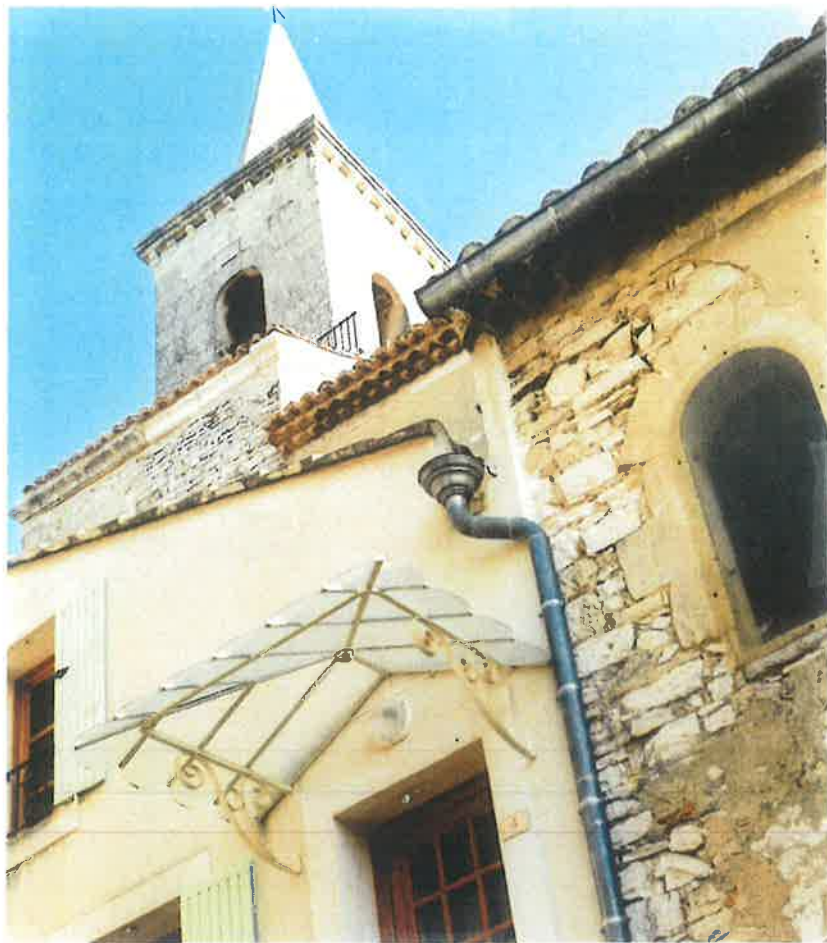
VUE.2. Sur une construction adossée à l'église et à la sacristie.
