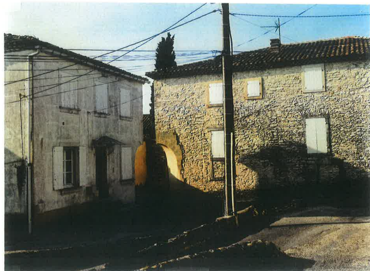
VUE . 2 . Vers la façade NORD où subsistent les traces de baies antérieures au 17 ème siècle
