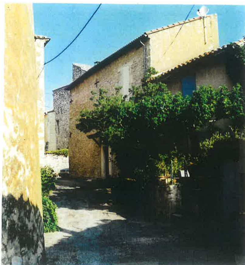
VUE.4. Vers la montée de la Rue des Pastres
