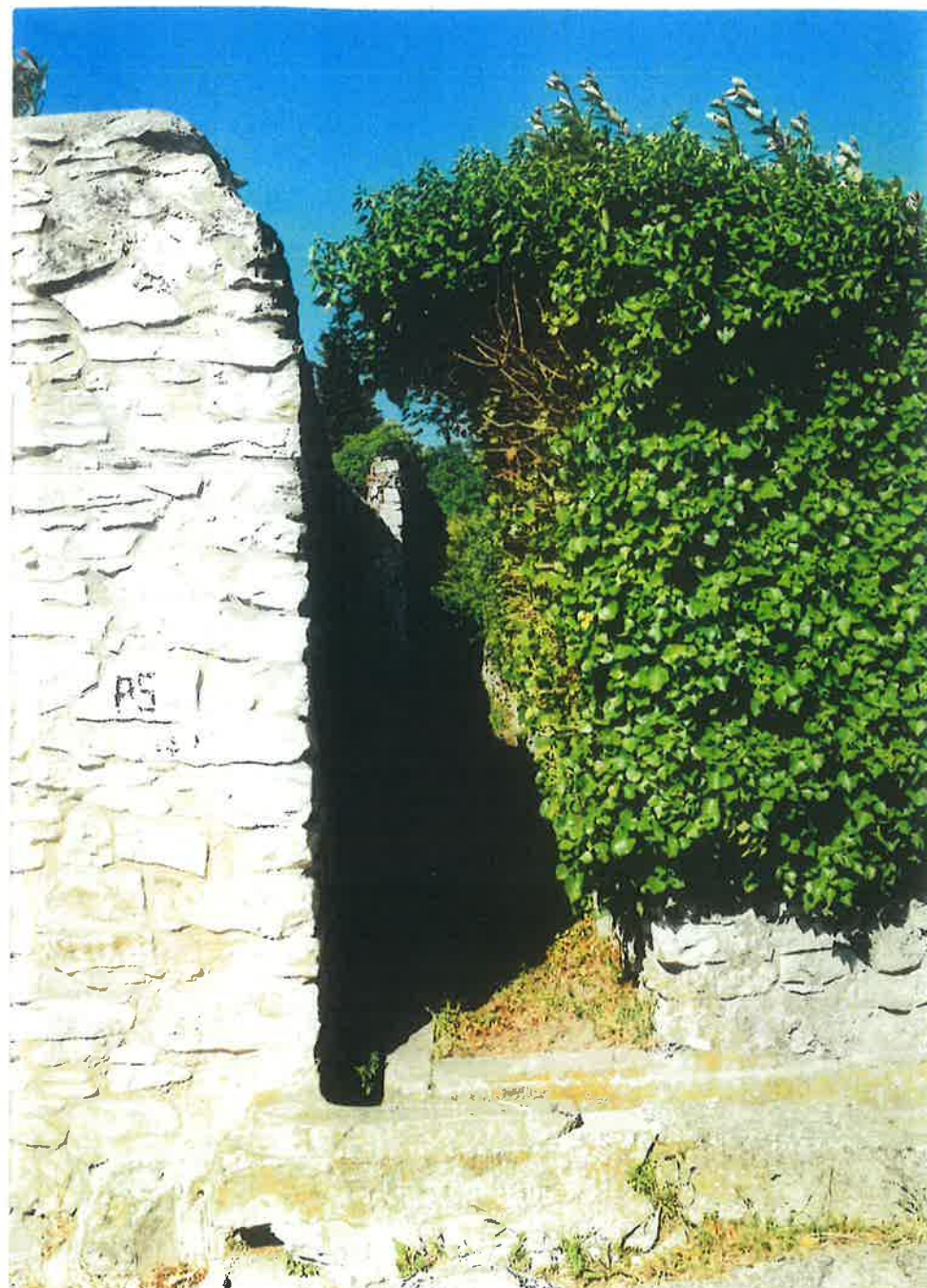
CANAL D'ARRIVÉE DE L'EAU, vue 1.
