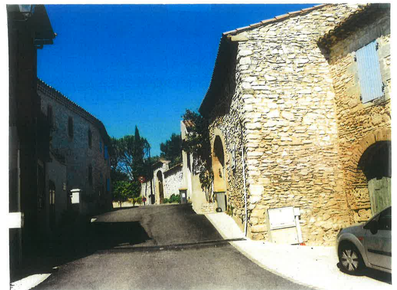
VUE .1 . Sur la Montée des Casalèdes et des chais.
