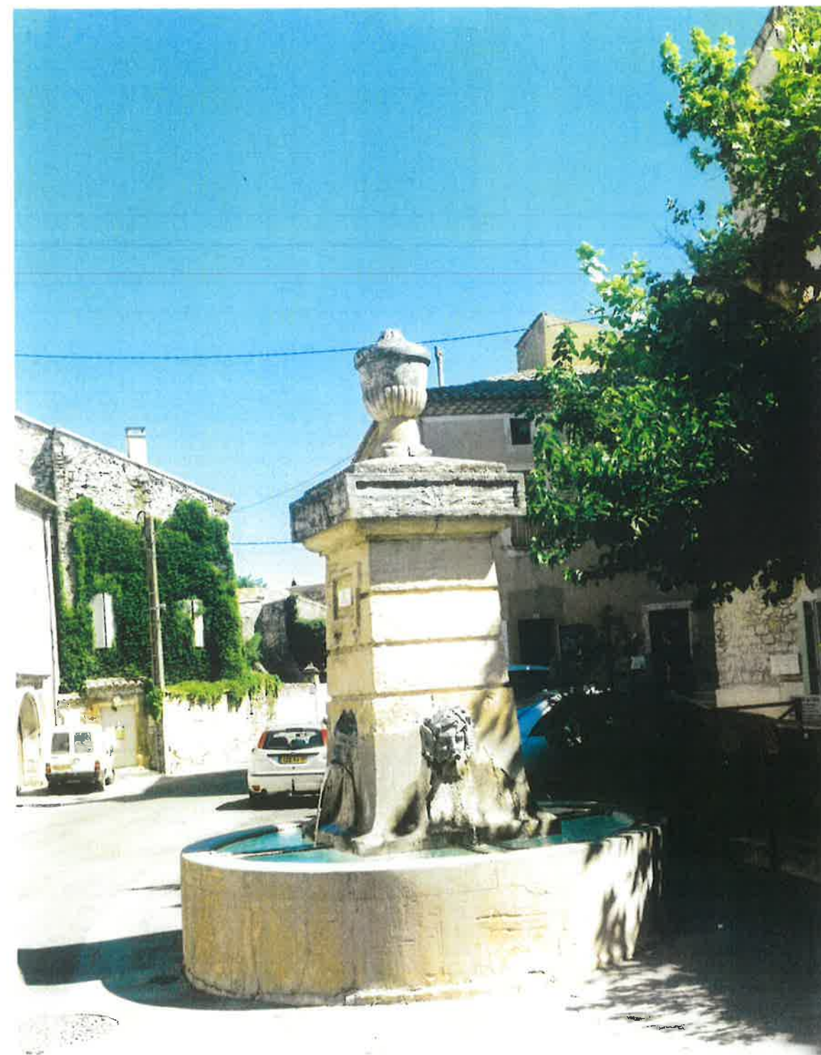
VUE.1. Sur la Fontaine communale, ouvrage du 19ème siècle.
