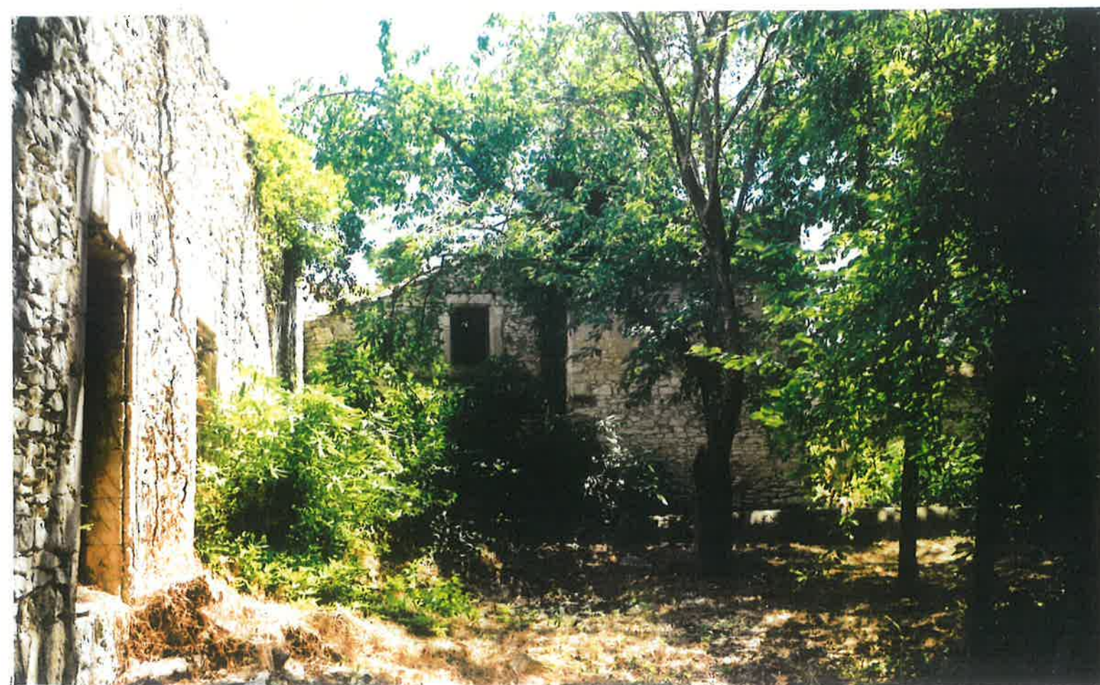
VUE SUR LE VIEUX MOULIN (à gauche la filature.), 2.
