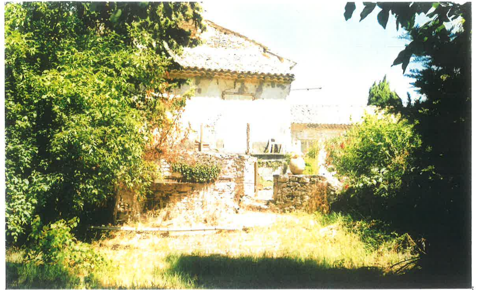
VUE DEPUIS LE BASSIN DE RETENUE VERS L'ENTRÉE AU CANAL D'ACCÈS A LA SALLE DES MACHINES (l'entrée a été obturée) .4.
