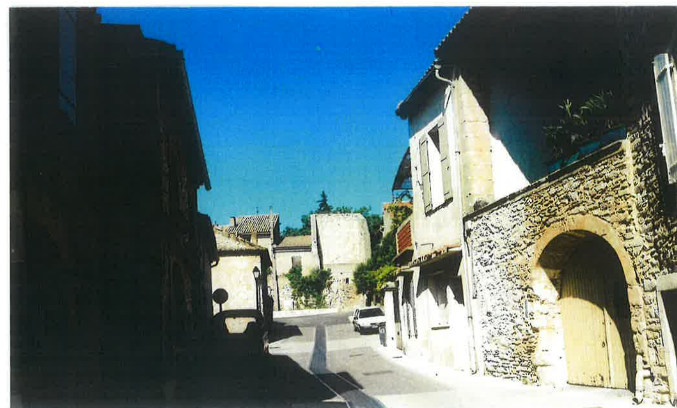
VUE.1. Depuis le milieu de la Rue Baron le Roy vers le croisement Rue des portails, Rue de l'Aspic.
