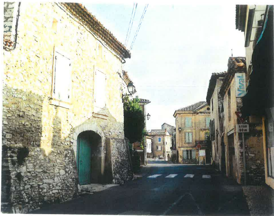
VUE .3 . Vers l'hotel de la mairie. Façade début 19ième siècle au premier plan
