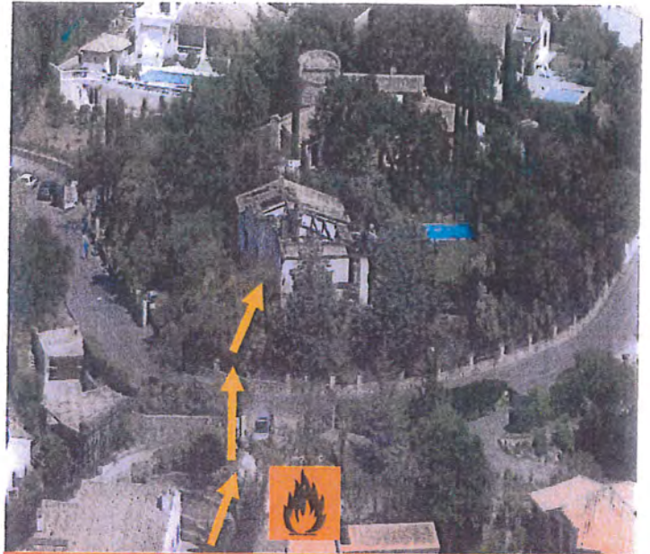
Maison de lotissement détruite par un feu de forêt. La haie du voisin a joué le rôle de vecteur.
